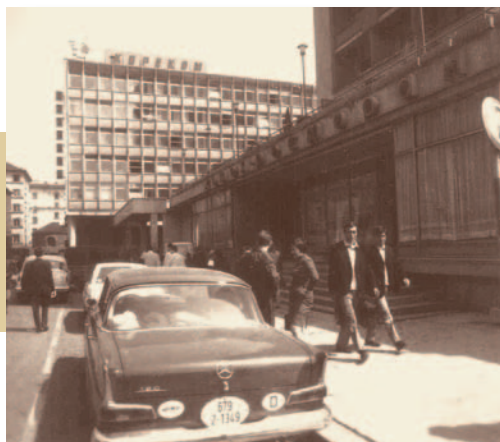
Централната сграда на външно- търговското предприятие „Кореком“ в София
